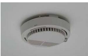
火災報知機 3個セットで取付け
