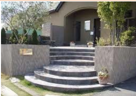
門・玄関・車庫の補修
