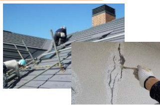
家の外観の補修
